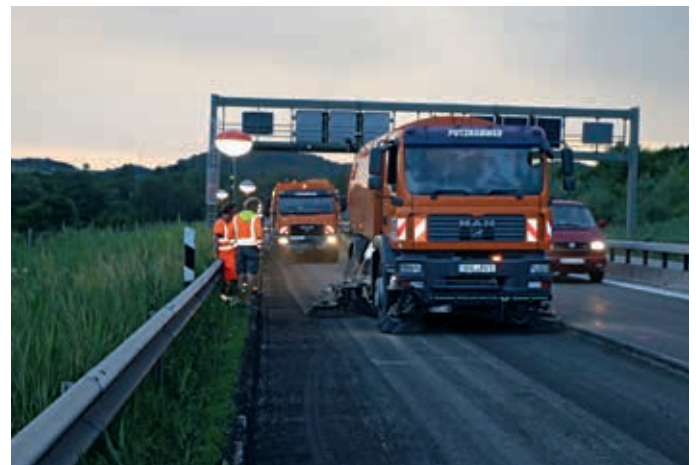
Vor dem Aufbringen der Bitumenemulsion wurde die Unterlage gereinigt.
