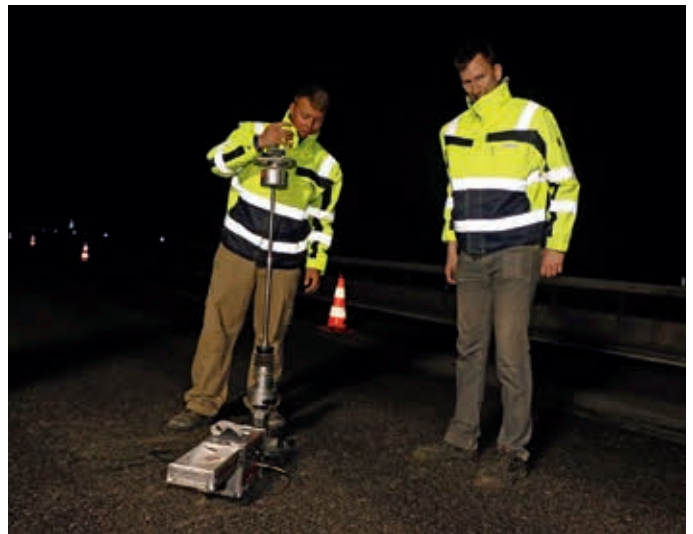
Michael Gehrke (r.) und Tim Bestgen analysieren die Verdichtung.
