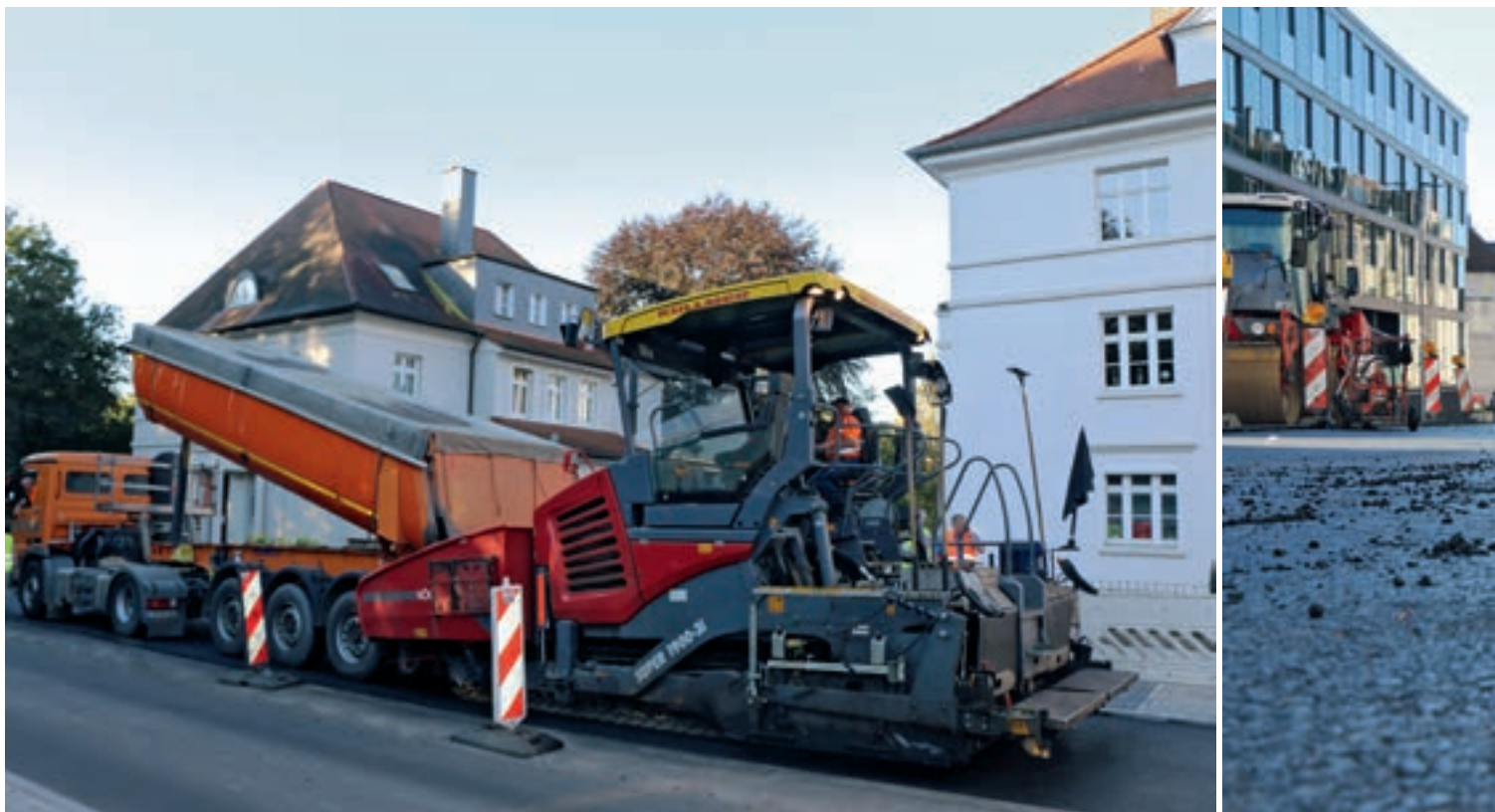
Der Einbau von Asphalt mit viskositätsverändernden Zusätzen hat in der Kurfürstenstraße in Fulda Premiere.
