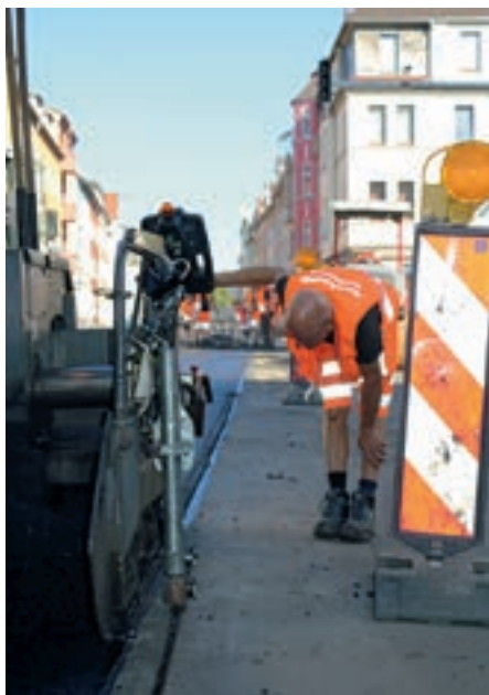
Für die einbauende Heinrich Küllmer GmbH & Co. KG verlief die Baumaßnahme problemlos.
