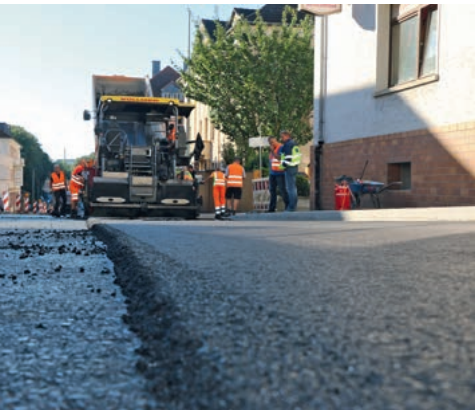
In Fulda wurde die Kurfürstenstraße komplett erneuert und umgebaut.
