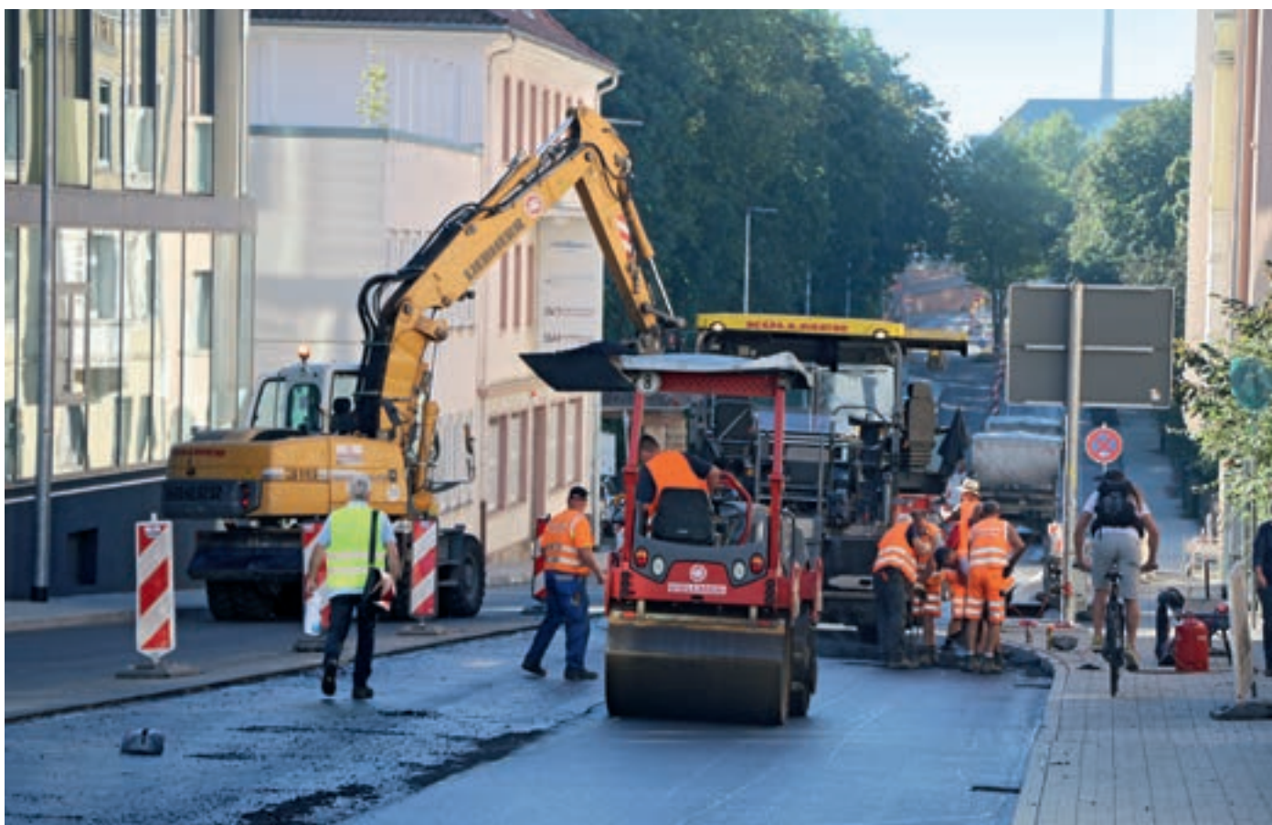
Die Berufsgenossenschaft der Bauwirtschaft (BG Bau) begleitete das Bauvorhaben in Fulda und führte Messungen zur Konzentration der Dämpfe und Aerosole aus Bitumen durch. (Quelle: DAV/hin)
