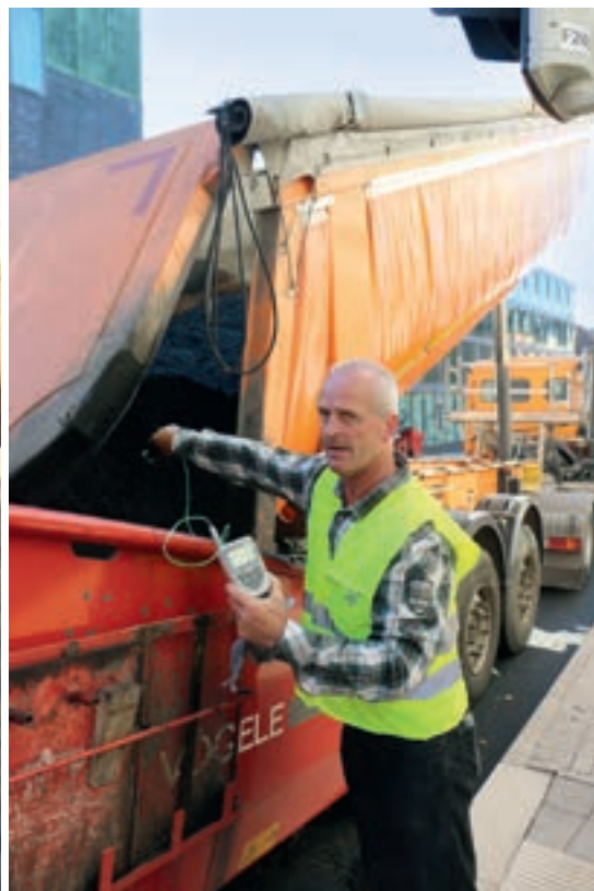
Horst Krenzer, Asphaltmisch- und Basaltwerk Suhl, misst kontinuierlich die Temperatur des Asphaltmischgutes.
