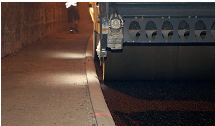
Maßarbeit beim Verdichten der Asphaltfläche.
