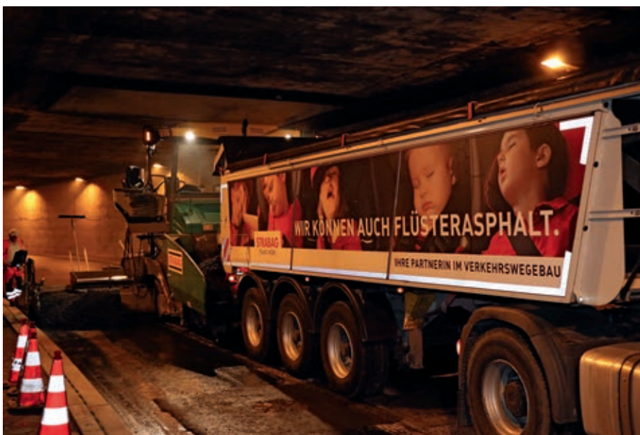
Aufgrund der geringen Tunnelhöhe konnten nur Mulden mit Abschieber eingesetzt werden.
