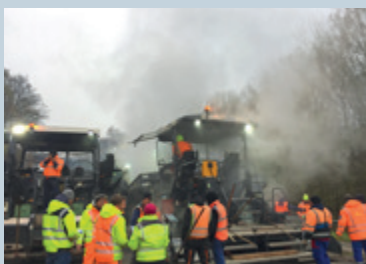
Standard Heißmischgut: 160 °C/Luft 5 °C
